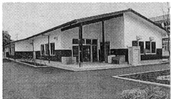
木造建築アドバイザー派遣により県内で初めて完成・供用した県立岱志高校工芸実習棟
